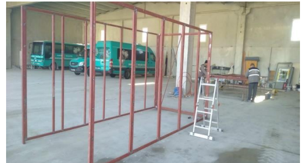
DURAK İMALATI ÇALIŞMASI
